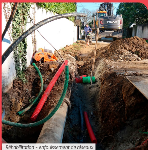
Réhabilitation – enfouissement de réseaux
