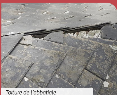
Toiture de l'abbatiale
