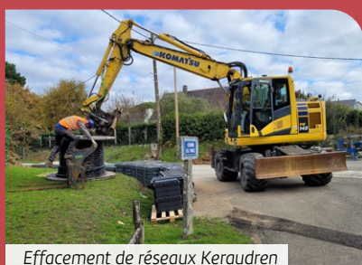
Effacement de réseaux Keraudren
