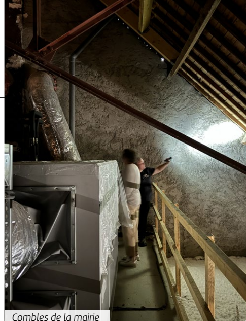
Combles de la mairie
