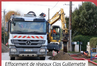
Effacement de réseaux Clos Guillemette
