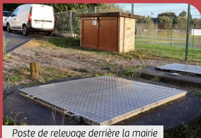
Poste de relevage derrière la mairie
