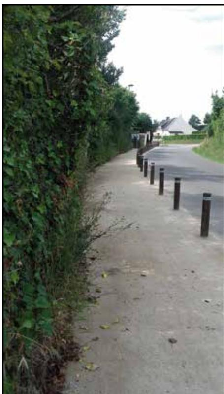
Réalisation route de Kernolivès d'une **voie douce** totalement sécurisée par des potelets imitation bois avec une bande fluorescente pour une meilleure visibilité de nuit, Le revêtement a été réalisé en « Nature sol » de couleur sable. Cette voie a une largeur suffisante pour les fauteuils roulants.
