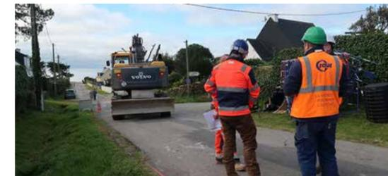
L'opération, d'un coût total de 429 500 € HT, porte sur des réseaux en amiante ciment, PVC et fonte pour les canalisations et béton pour les ouvrages de visite, ainsi que PVC, béton, amiante et fonte pour les boîtes de branchements. Elle comprend la dépose de canalisation amiante, en partie, la
