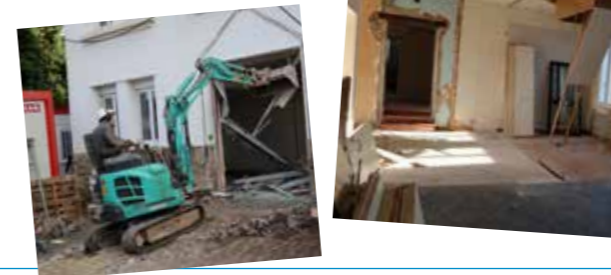
Les travaux avancent !
