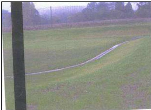
Dans l'hypothèse de noues ou de dépressions paysagères, elles seront également enherbées. Les pentes de talus seront au maximum de 25% et devront avoir un profil en travers se rapprochant le plus possible d'une courbe sinusoïdale. On recherchera le plus possible à se rapprocher des caractéristiques et de l'intégration des aménagements ci-dessous.
